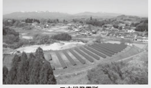
二本松発電所
